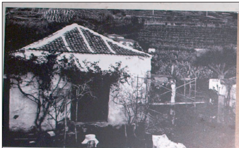
Figura nº 17. Fotografía décadas de 1920 o 1930. Colección José Brier Bravo de Laguna. Instantánea de la Ermita de San Cristóbal en la Quinta Roja en la que se observa la inexistencia de la espadaña y del muro perimetral que actualmente cierra el patio.
